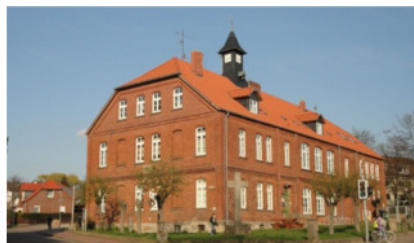
Schule nach einer Aufstockung, Aufn. 2011
