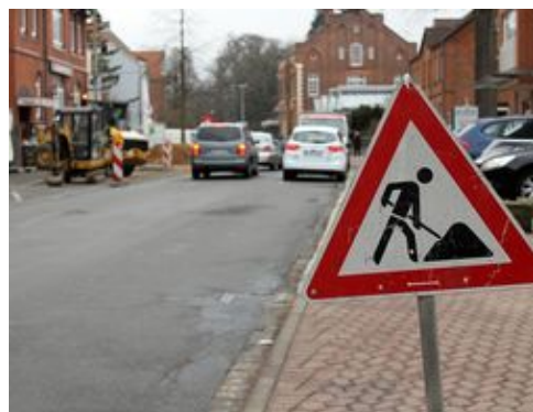
Baustelle Hauptstraße Wennigsen. Foto CON-nect
