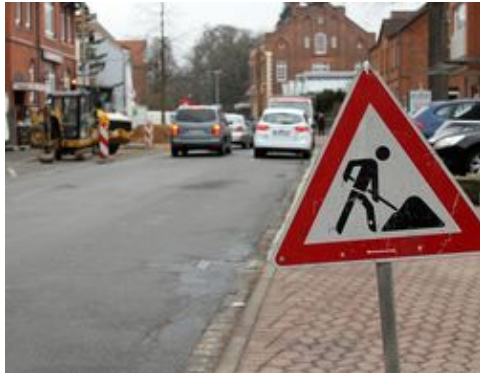
Baustelle Hauptstraße Wennigsen. Foto CON-nect
